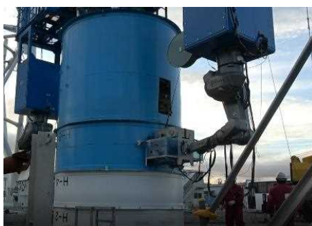
筒身外周切断状況
