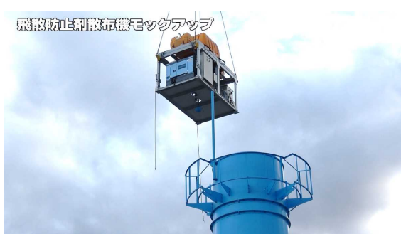
飛散防止剤散布装置据付
