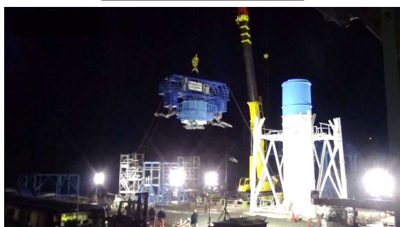
筒身切断作業状況(夜間)
