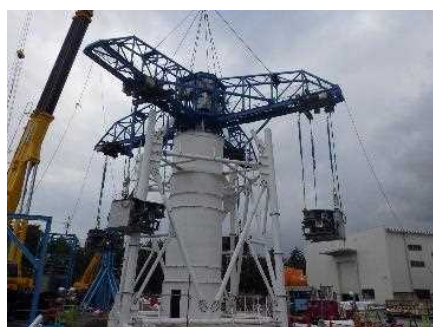
支柱材解体状況
