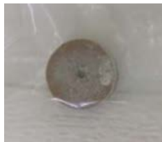
コンクリートコア外観 (4RB-1F-C-E2)
