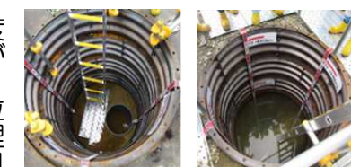
(陸側遮水壁) (陸側遮水壁) 内側 外側
