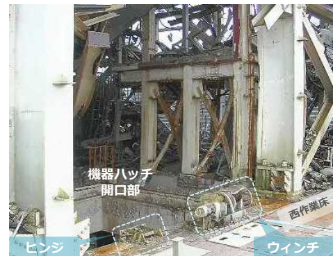
機器ハッチの状況（西作業床より）
