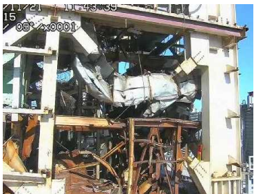
撤去後の南面（11月21日）
