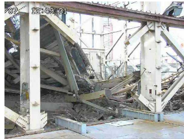
撤去後の東面1（12月7日）
