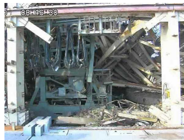
撤去後の東面2（12月20日）
