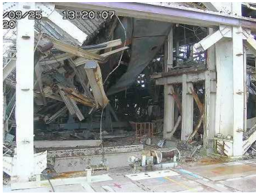
撤去後の西面（9月25日）
