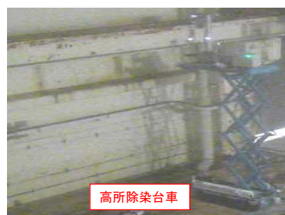
⑤高所空間/表面線量率測定状況
