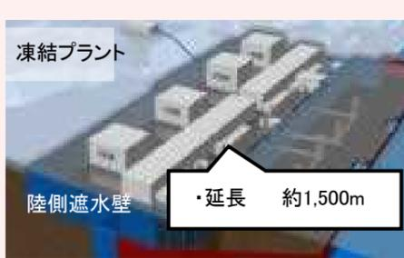
建屋への地下水流入を抑制するため、建屋を囲む陸側遮水壁の設置を計画。2016年3月より海側及び山側の一部、2016年6月より山側の95%の範囲の凍結を開始。残りの箇所についても段階的に凍結を進め、2017年8月に全ての箇所の凍結を開始。
