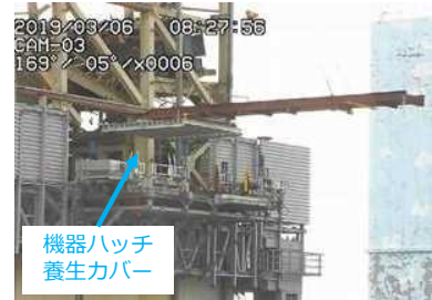
機器ハッチ養生カバー設置の様子 ※大型吊り天秤とクレーンを使用
