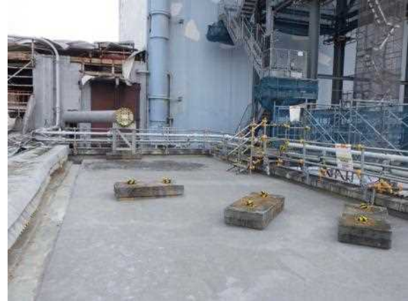
FSTR建屋片付け状況
