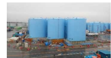
(溶接型タンク設置状況)
