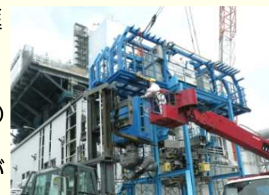
解体装置組立状況
