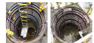
陸側遮水壁 内側 陸側遮水壁 外側
