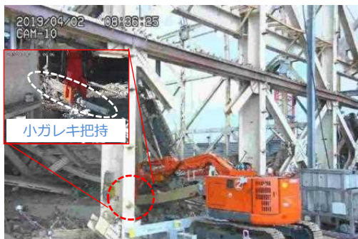
遠隔操作重機による作業状況
