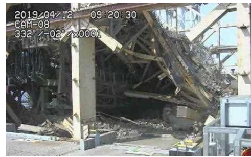
小ガレキ撤去状況
