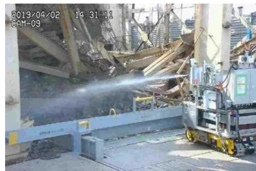
飛散防止剤散布状況
