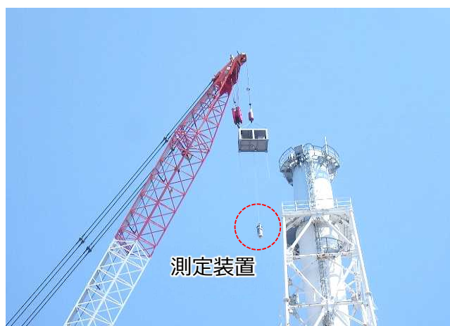
解体前調査の実施状況
