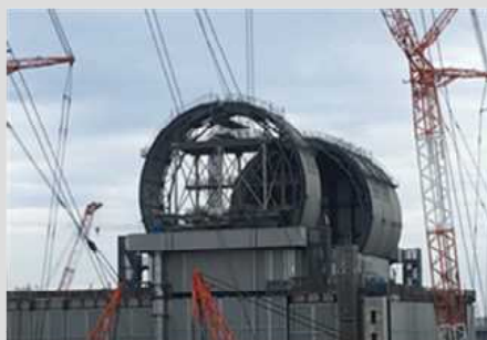
燃料取り出しカバー設置状況
