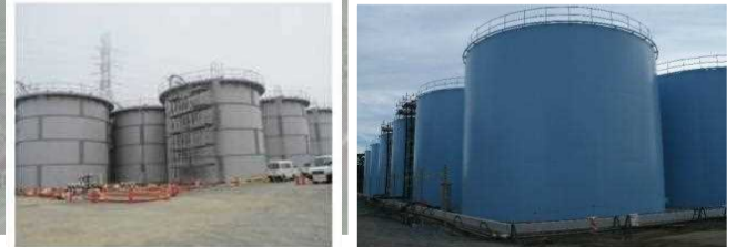
タンクの設置状況
