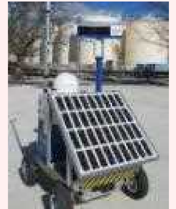
線量率モニタの設置状況
