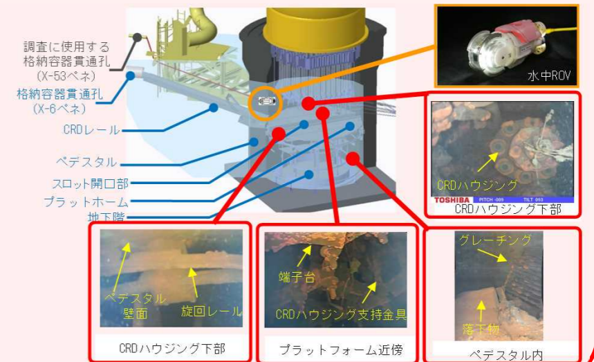
ペDESTAL内部の状況
