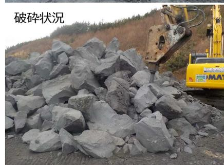
写真④: 人工地盤材料製造状況
