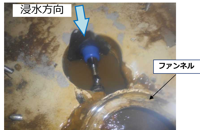
コア抜き箇所の流入抑制状況
