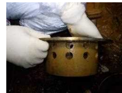
②を取外した状況
