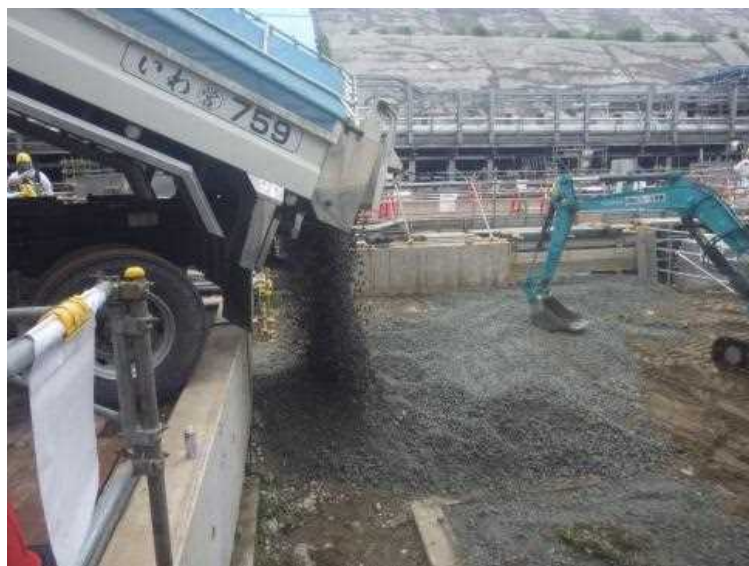
路盤整備状況（碎石搬入）撮影日：6/11
