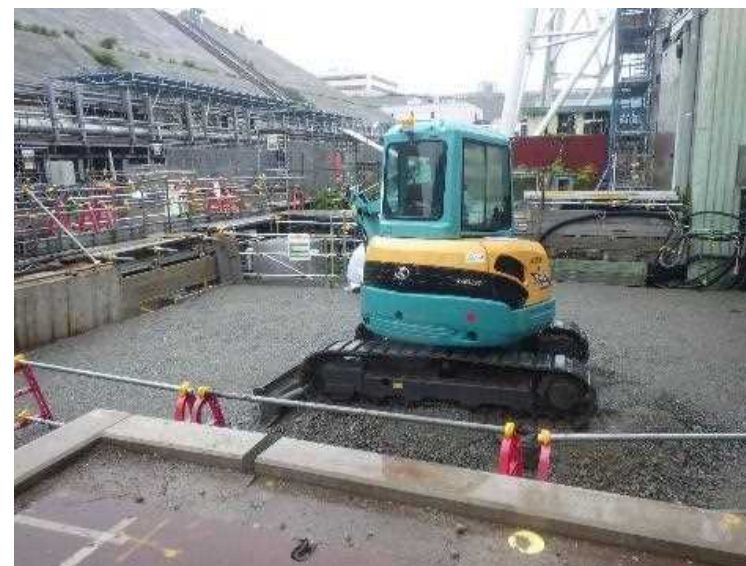
路盤整備状況（整地）撮影日：6/15
