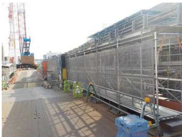
1 / 2号機排気筒：西側
