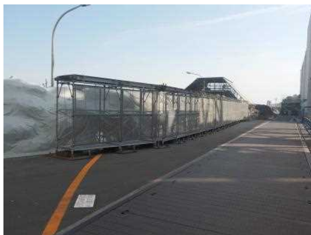
タービン建屋集中排気筒：東側
