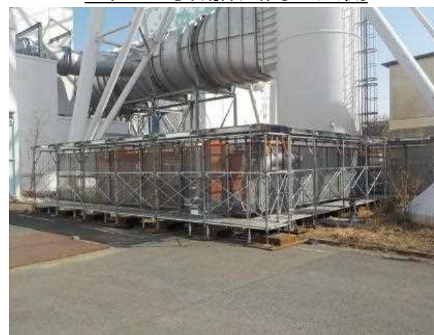
5 / 6号機排気筒：北側
