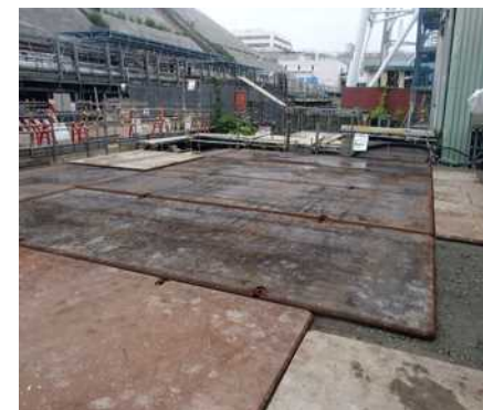
④ 敷鉄板設置
