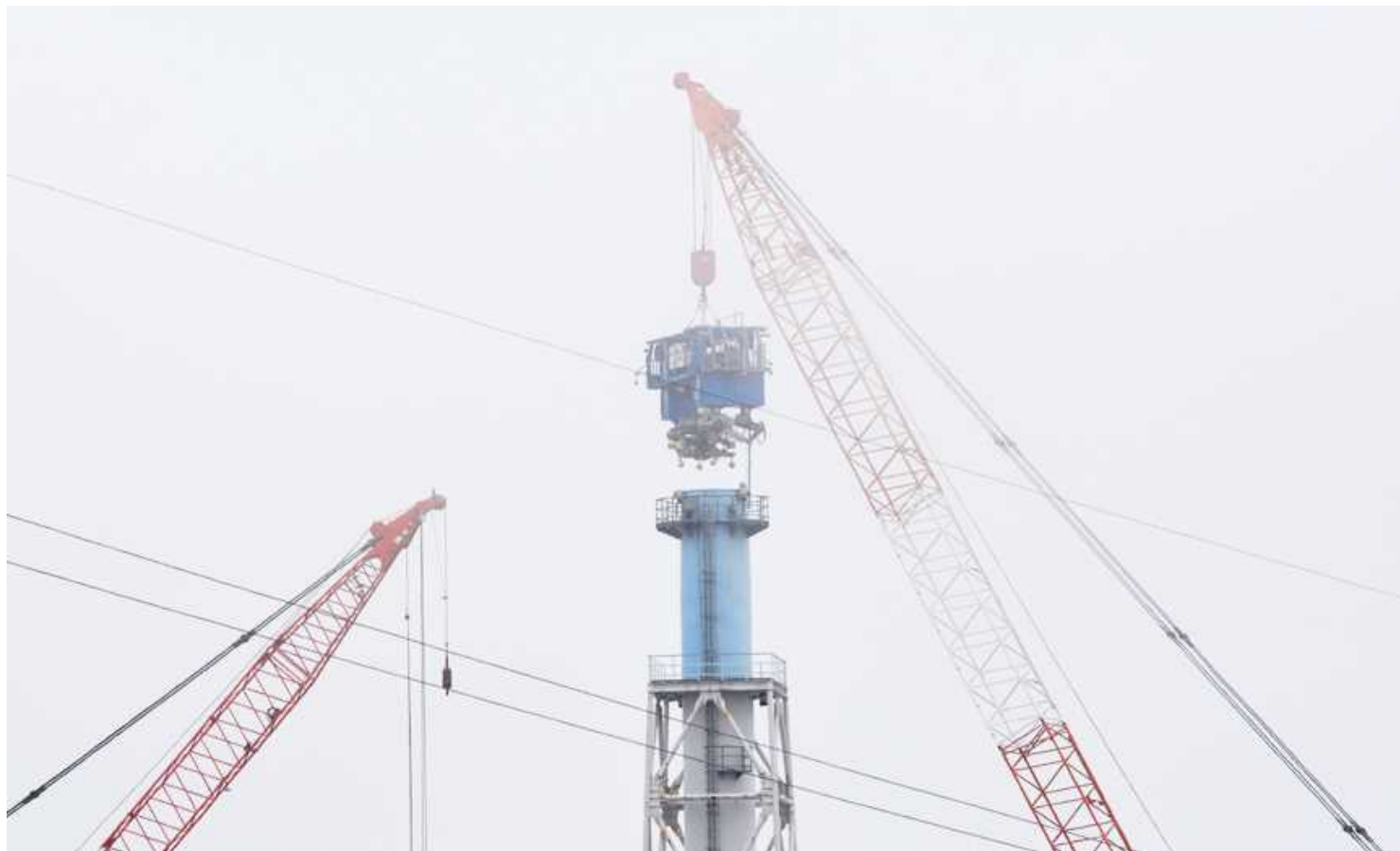
クレーン高さ確認の作業状況
