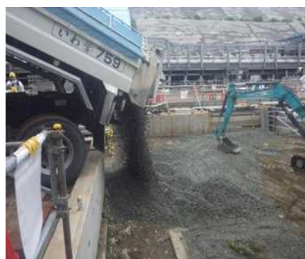
① 碎石敷き込み
