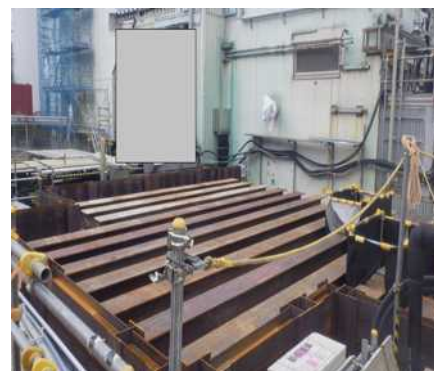
③ 補強鋼材設置
