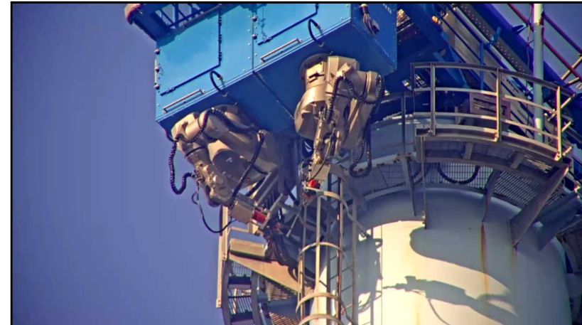
【写真②】 背カゴの切断作業写真（8月1日）
