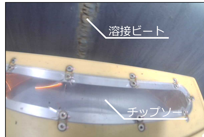
【写真④】 筒身内部の切断状況(8月7日)
