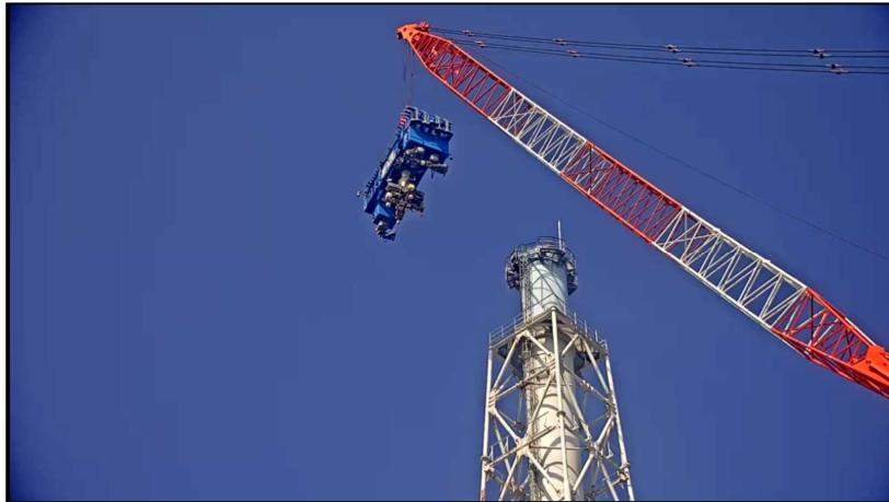
【写真①】 解体装置の設置状況（8月1日）
