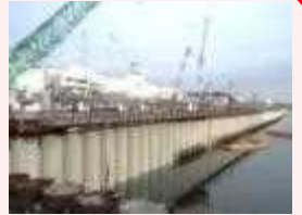
海側遮水壁 鋼管矢板打設完了状況
