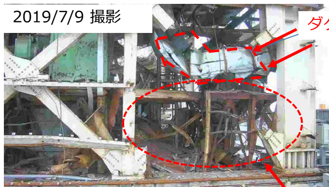
南側小ガレキ撤去前
