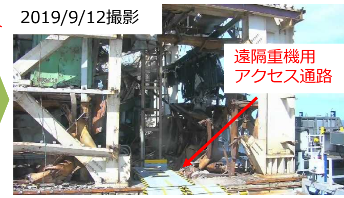
南側小ガレキ撤去後
