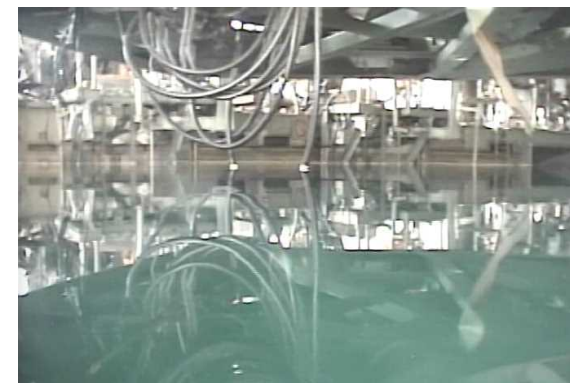
水面上の状況 (調査2) (撮影日2019年9月20日、水面上)
