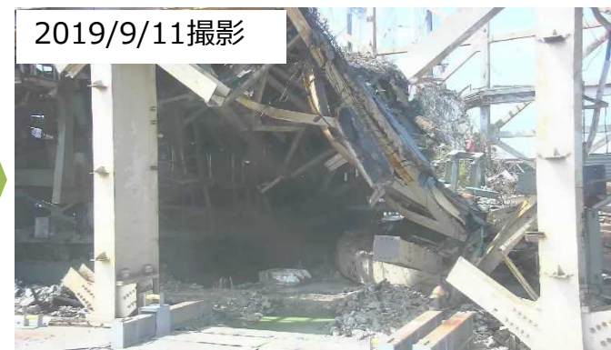
SFP上の鉄骨撤去後
