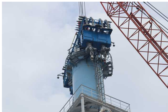
【写真①】切断作業状況・外側(9月1日)
