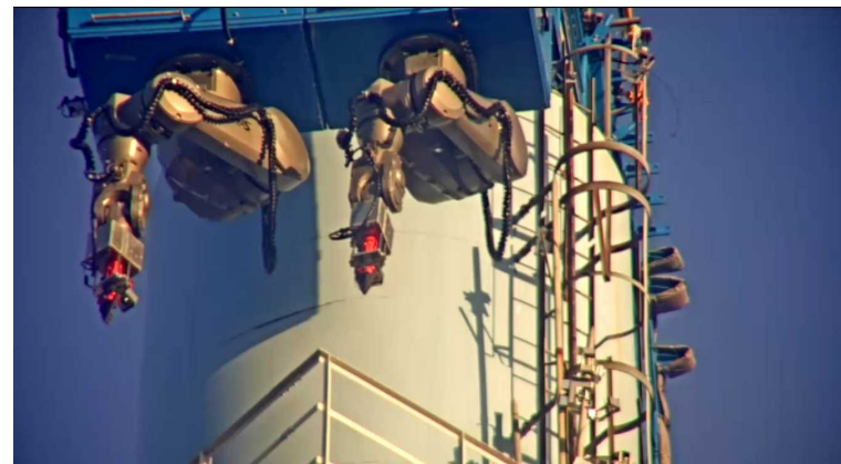
【写真⑥】 筒身切断状況 (9月18日)
