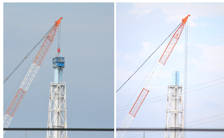
【写真④】解体前後の比較（9月1日）
