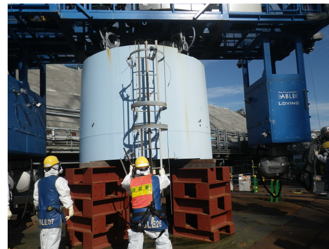
【写真⑧】 吊り下ろし後 (9月26日)
