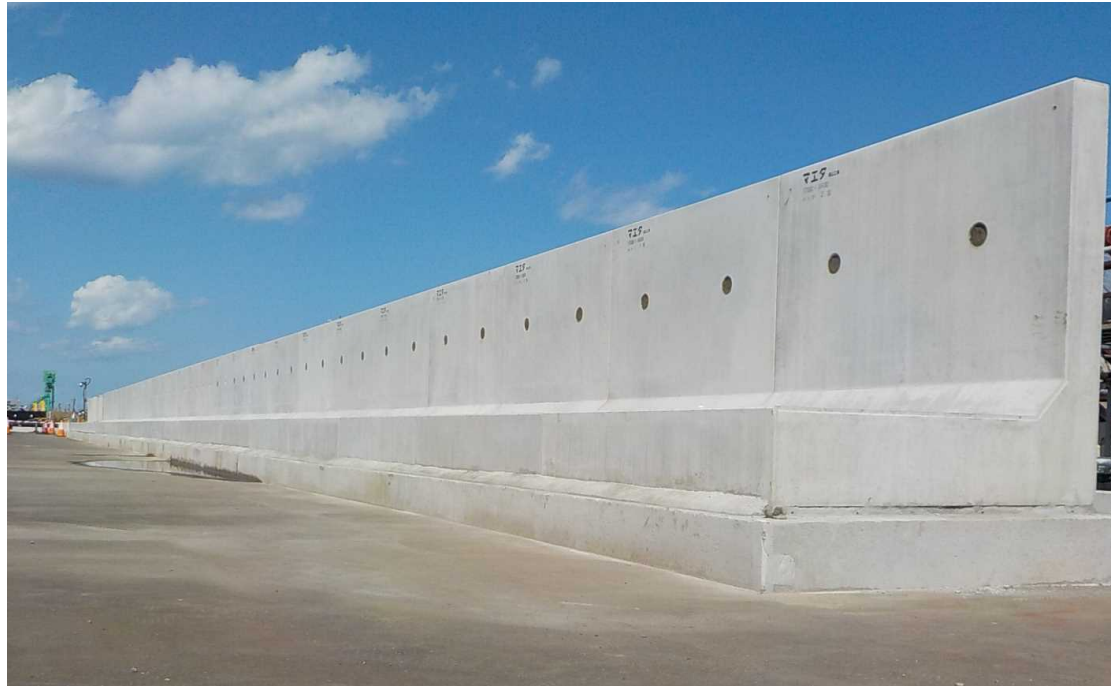
現地据付状況（9月25日撮影）
