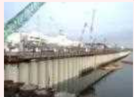
海側遮水壁 鋼管矢板打設完了状況
