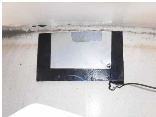
①鉄板をダクトテープ養生
