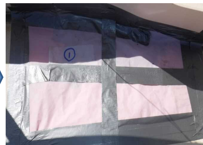
③ビニール養生
