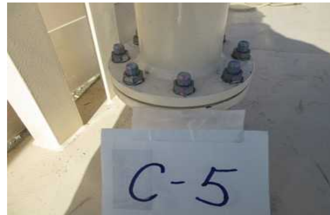
⑤ベント管復旧
