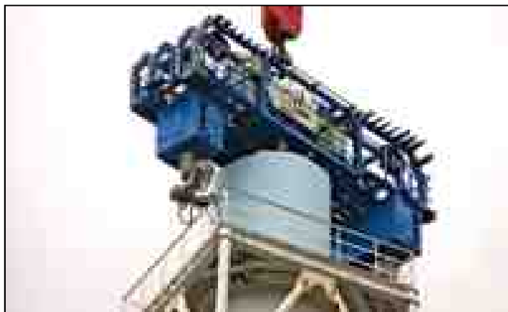
【写真①】筒身切断状況(10月8日)
