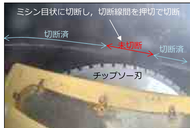
【写真②】筒身切断(マシン切)状況 (10月21日)
