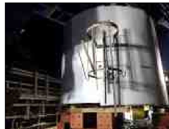
【写真④】吊り下ろし後 (10月22日)
