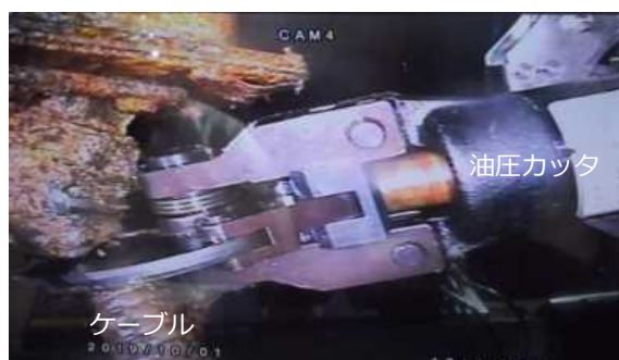
ケーブル切断の様子
