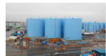
(溶接型タンク設置状況)
