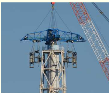
斜材切断状況
