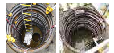
陸側遮水壁 内側 陸側遮水壁 外側
