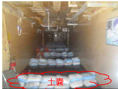
PMBの土嚢設置時の状態 ※震災直後に、PMBに貯留する滞留水中の放射性物質を吸着するため約16t投入
