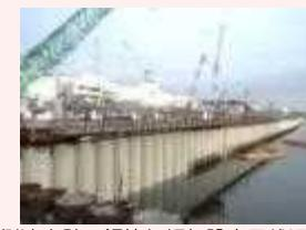
海側遮水壁 鋼管矢板打設完了状況
