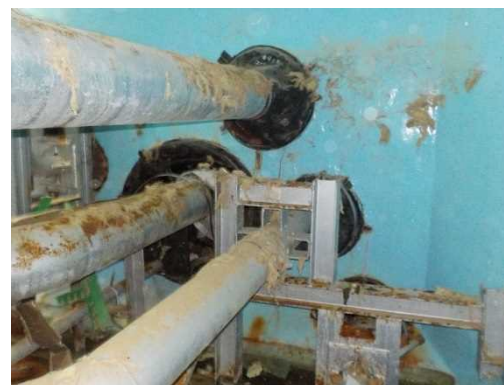
①配管ダクト内の状況
