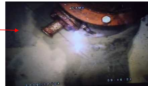
モルタル硬化の様子 (12/4)
