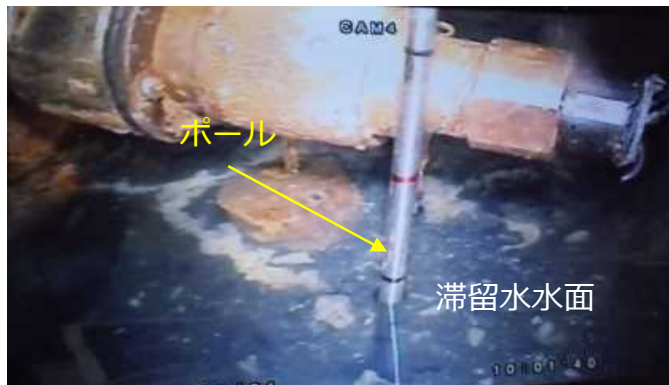
操作ポール挿入後 (12/4)
