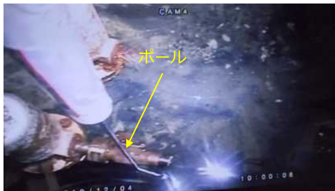
操作ポール挿入前 (12/4)
