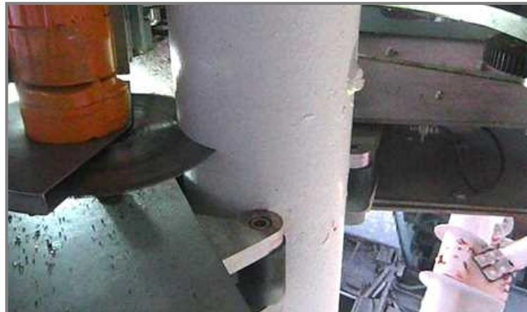
【写真③】斜材切断状況 (11月7日)
