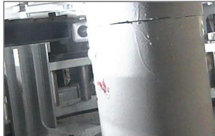
【写真④】主柱材切断状況(11月26日)
