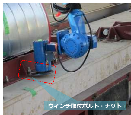
チップソーによるボルト・ナットの切断
