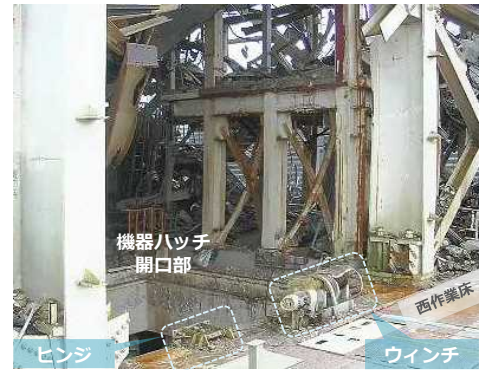
機器ハッチの状況（西作業床より）
