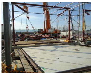
養生カバー設置完了
