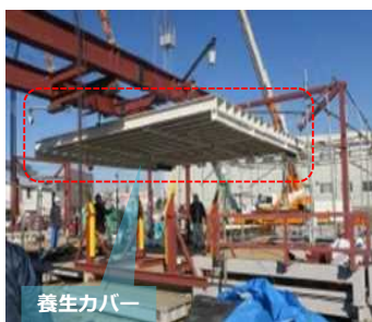
養生カバー搬入
