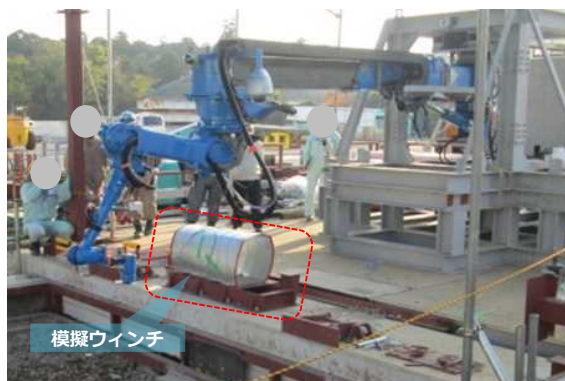
ロボットアームによる作業
