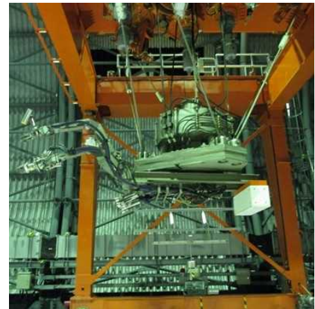
テンシルトラス吊り上げ状態
