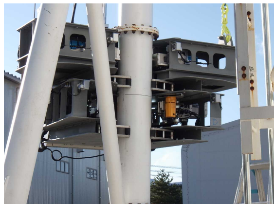
主柱切断作業の状況
