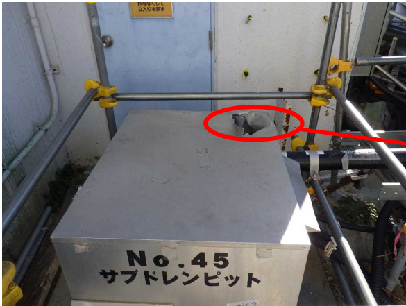
落下してきた足場で損傷した サブドレンカバー
