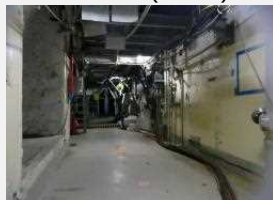
【撤去後】(矢視C)
