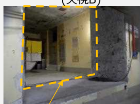
【ブロックアウト撤去後】(矢視B)
