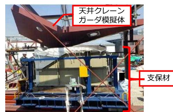
④支保材型枠上昇、モルタル充填
