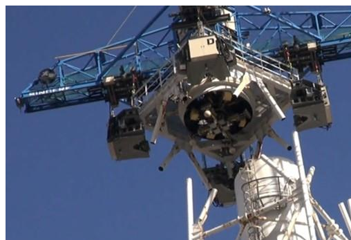
図5 1/2号機排気筒の解体開始（2019年8月）
