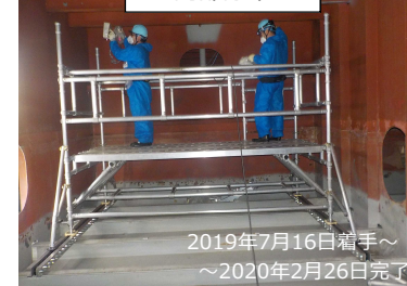
写真⑤: メガフロート内部での除染状況
