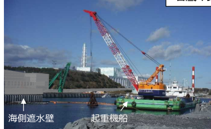
写真②: 起重機船による人工地盤材料投入状況
