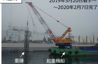
写真③: 起重機船による着底マウンド均し状況
