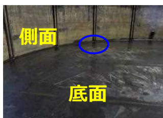
【参考】同型タンク内面写真（水抜き後）
