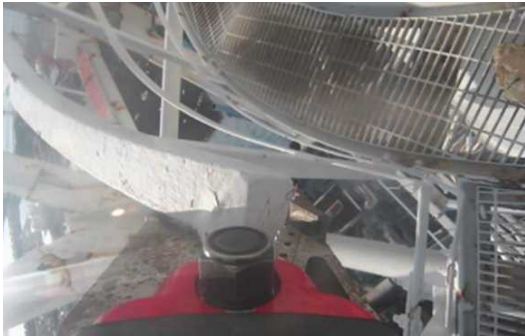
12ブロック目鉄塔解体作業(2月24日)
