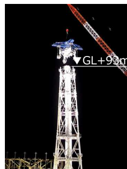
11ブロック解体時 (2020年2月1日)
