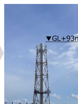
11ブロック解体後 (2020年2月4日)
