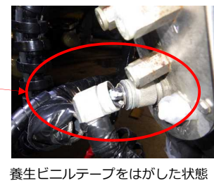
養生ビニルテープをはがした状態
