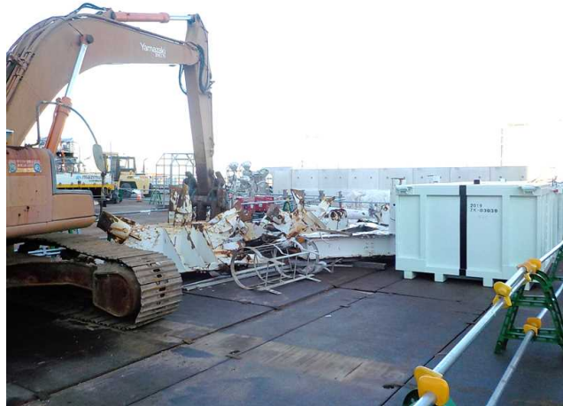
【写真②】鉄塔の小割状況（小割ヤード：8.5m盤）
