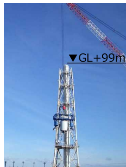
9ブロック解体後 (2020年1月17日)
