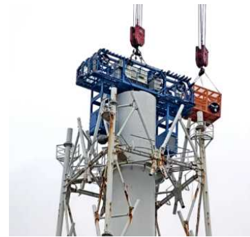
搭乗設備 作業状況
