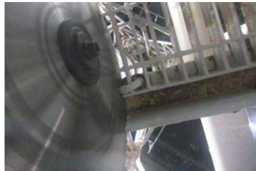
12ブロック目鉄塔解体作業(2月24日)
