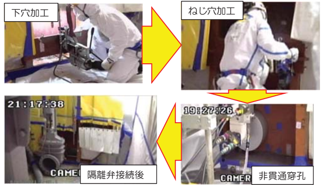
図1 隔離弁接続作業
