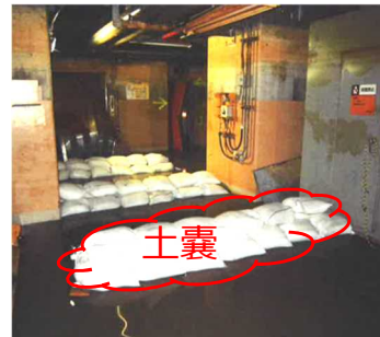
HTIの土嚢状態(設置時)
