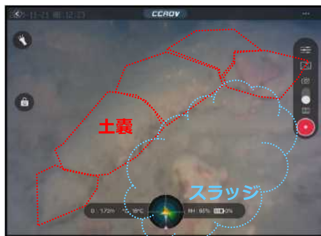
HTIの土嚢周辺状態(現在)
