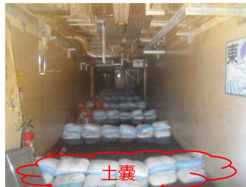
PMBの土嚢設置時の状態
