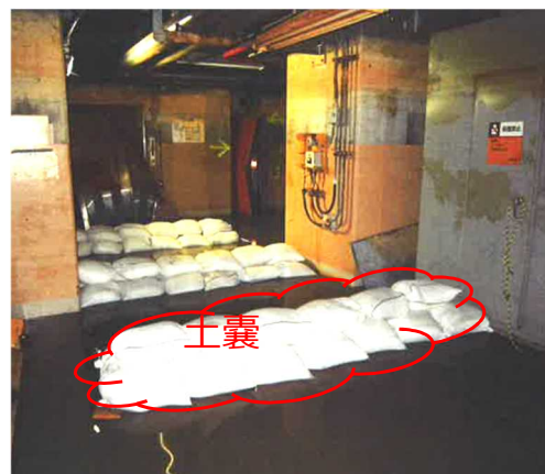
HTIの土嚢状態(設置時)
