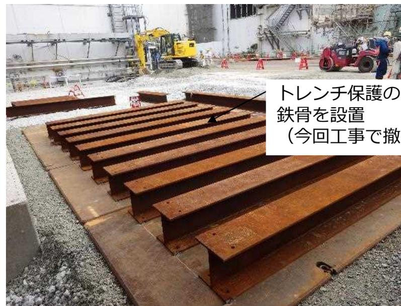
トレンチ保護のため補強鉄骨を設置
