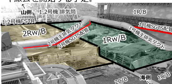
【図1】Rw/B全景写真 東側(2T/B屋上)より撮影 2018年7月
