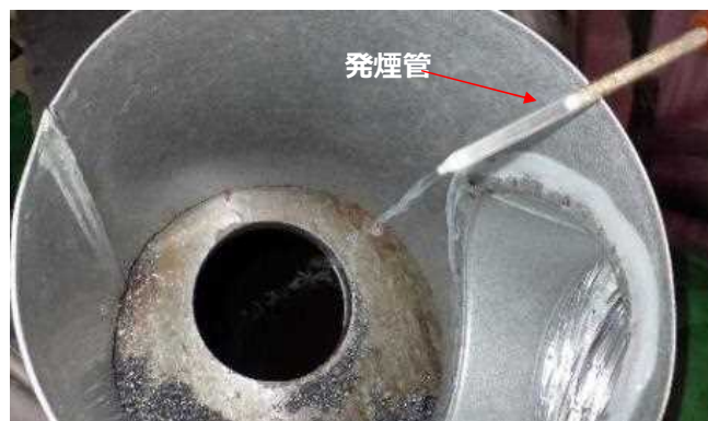
オフガス系配管穿孔状況 (φ100mm 穿孔後 airflow 確認)
