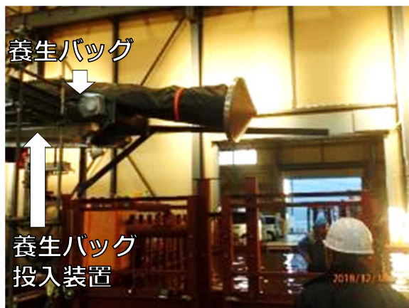
①養生バッグ投入
