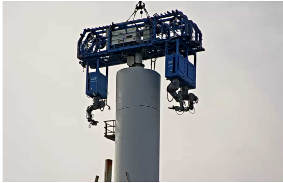
18ブロック目筒身解体作業(4月7日)
