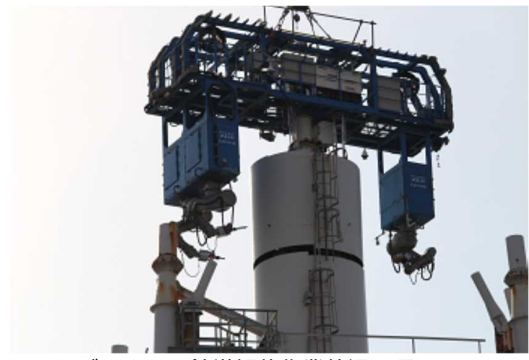
23ブロック目鉄塔解体作業状況(4月29日)
