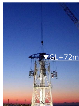
19ブロック解体中 (2020年4月10日)
