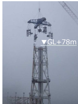
17ブロック解体中 (2020年3月29日)
